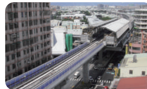
桃園機場捷運系統CE01C施工標
