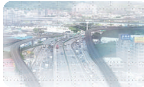
國道1號五股交流道增設北入及北出匝 道改善工程(第I103S標)
