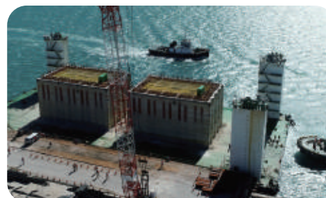
第三座液化天然氣接收站建港及圍堤造地新建工程
