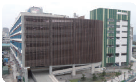
代辦臺北市市場處所屬公有環南市場 改建工程
