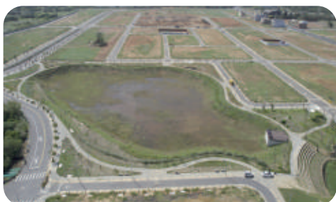
桃園市草漯第一、三、六區整體開發 單元市地重劃工程
