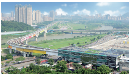
臺北都會區大眾捷運系統環狀線 CF640 區段標工程
