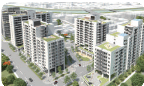
三峽國光段(二期)青年社會住宅新建統包工程
